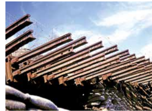
למעלה: פסי רכבת שפורקו מקו מסילת הרכבת בצפון חצי האי סיני ושימשו - בתוספת בטון, עפר ושכבת אבנים - מרכיב בשכבת ההגנה של המעוז
