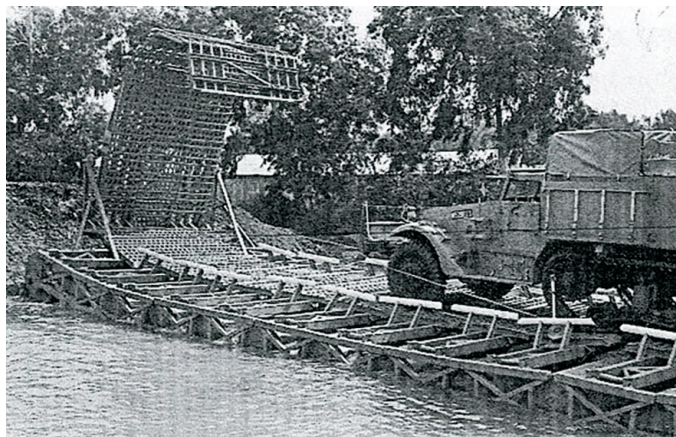
גשרון גלילים מוקטן לזחלמים עם כבש קדמי מורכב. יחידת יפת"ח, באדיבות משה פרנקל.
