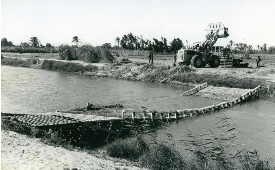
גשר כלובים בתעלת מים בגדה המערבית. אוסף המחבר.
