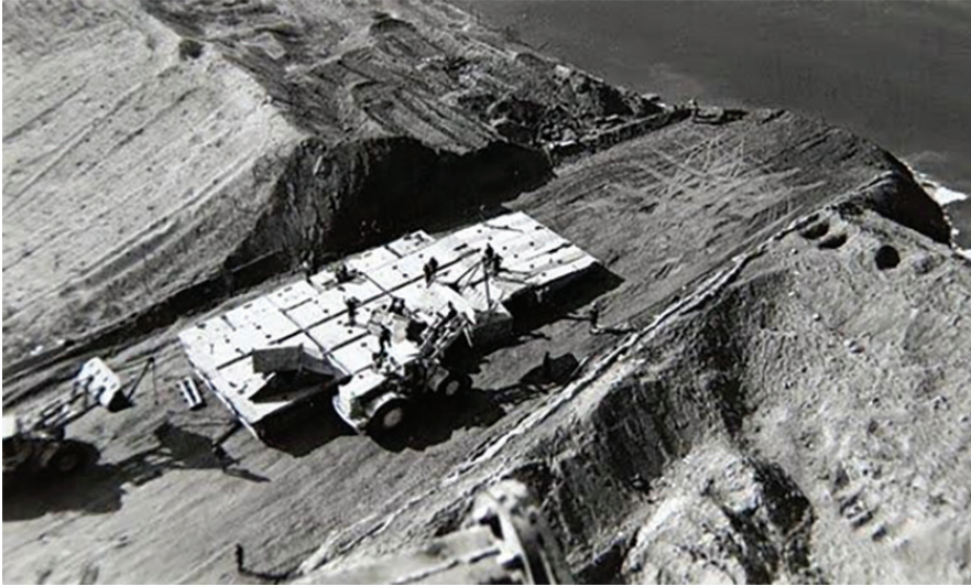
חלקת גשר מנהלתי מושקת לתעלה. אוסף המחבר.
